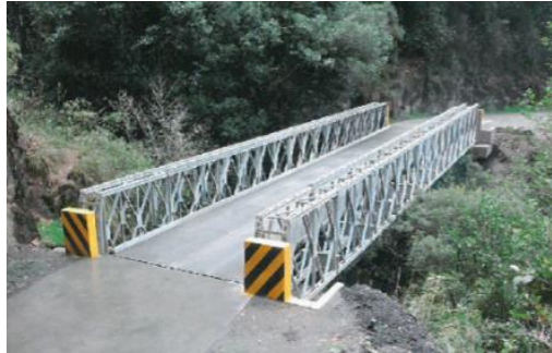
Imagen de referencia – Puente Modular Vehicular
