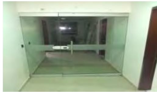
Figura N. 4 - 18 Puerta vidrio seguridad con lectora FASAB
