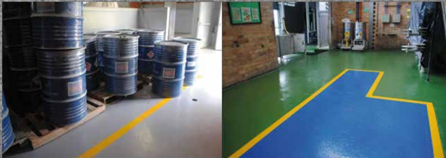
Piso epóxico en Planta de emulsiones
