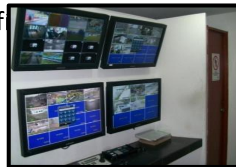
Remodelación Instalaciones Oficina de Seguridad.
