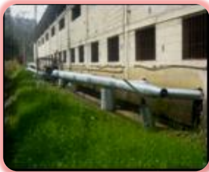
Figura No. 2- 53. Sistema de ventilación local exhaustiva para la captación de humos de soldadura y corte
