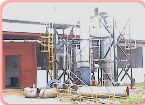
Figura No. 2- 43. .Traslado sistemas de aspiración de finos Planta de Microfundición
