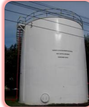
Figura No. 2- 71. Cuarto Sistema de Bombeo y Tanque de Almacenamiento Red Contra Incendio Fagecor
