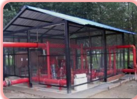
Figura No. 2- 71. Cuarto Sistema de Bombeo y Tanque de Almacenamiento Red Contra Incendio Fagecor
